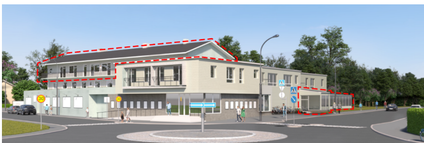
Vy 2 sett från korsningen Snöripsvägen, Svartlösavägen. Inom röd streckad linje illustreras föreslagen påbyggnad samt tillbyggnad mot Svartlösavägen. I övrigt visar bilden befintlig bebyggelse.
