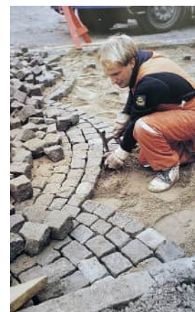
Från vänster: Montage av stålstomme och prefab-bjälklag i betong. Stenläggning med smågatsten. De nya fasaderna mot Hazeliusbacken. Parasollbord. Bilder hämtade från Fabège JM (1992).
