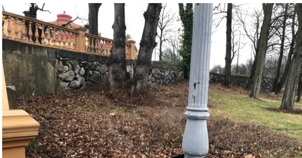
Terrassmur från 1800-talet med nyare pågjutningar av betong. Muren ligger i anslutning till den nuvarande parkeringsplatsen. Fram till flytten 1963-65 låg Gubbhyllan på platsen och muren är uppförd i anslutning till denna.
