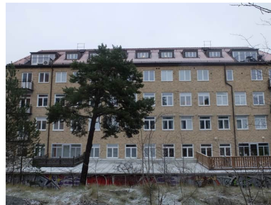
Fasad mot baksidan i väster. Lågdelen är ursprunglig från 1940-talet. Plåttäckning, träräcken och aluminiumdörrar som leder till terrasserna är senare tillkomna.
