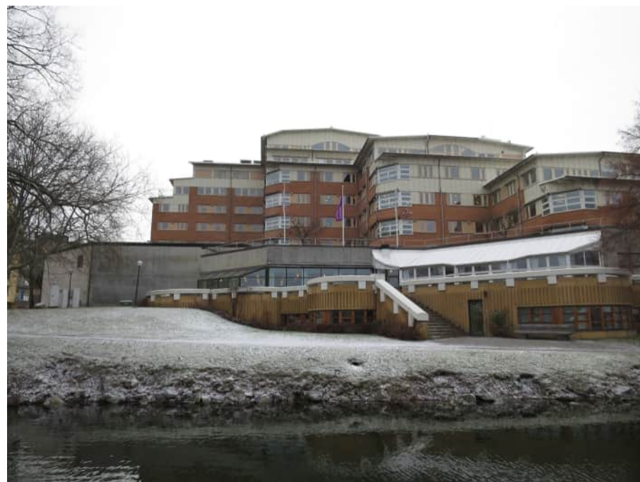
Mot vattnet har byggnaden en plastisk form som trappar sig i flera nivåer. Fasadmaterialen är många och går från betong med tungt uttryck närmst mark till lätta plätvolymmer högst upp.
