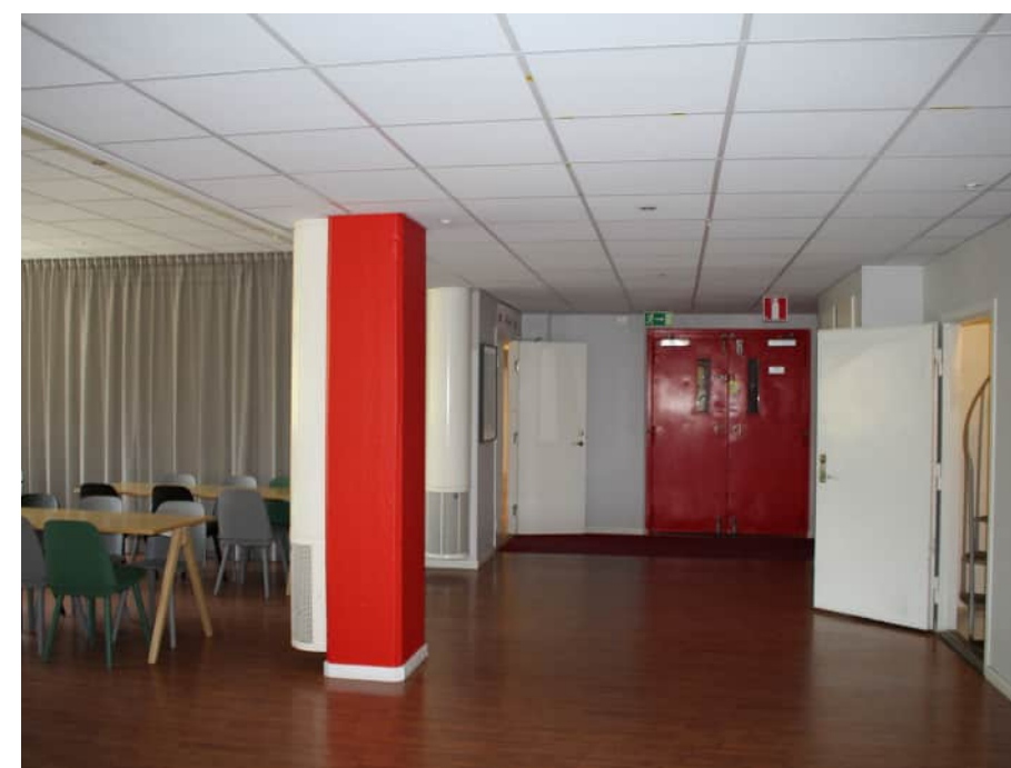
Ytskikt är generellt sentida och undertak har tillkommit. Pelare, hissdörrar och spiraltrappa (till höger i bild) tillhör ursprungliga detaljer som finns kvar i byggnaden.
