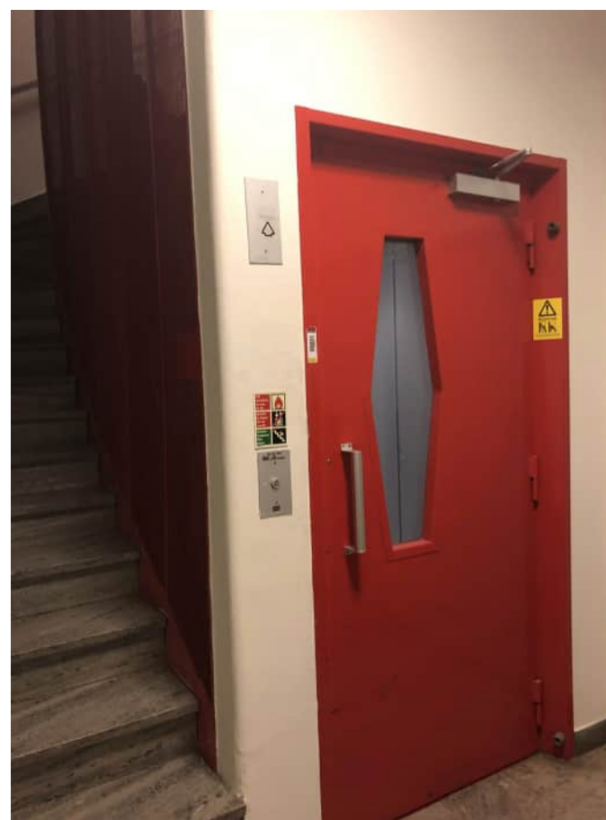
Det lilla trapphuset med hiss i ursprungligt läge. Trappan är klädd i kalksten. Hissdörren är sannolikt ursprunglig.
