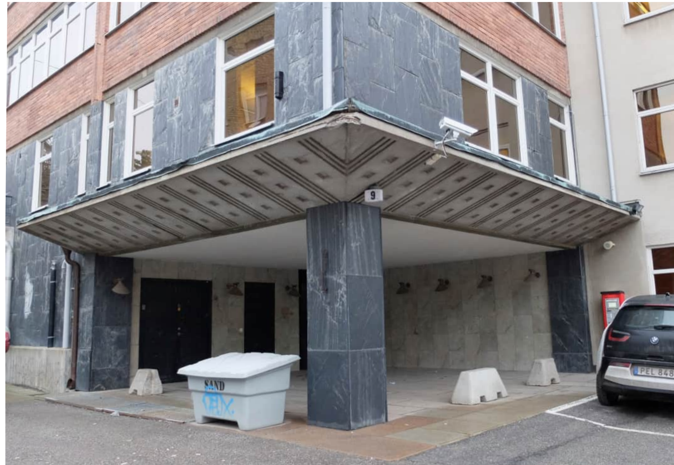
Den i hörnet indragna entrén har ett uppvinklat tak med undersida av bearbetad betong med mönster och kopparklädd ovansida. Entréportar har bytts ut men dörrsättningen är bevarad.
