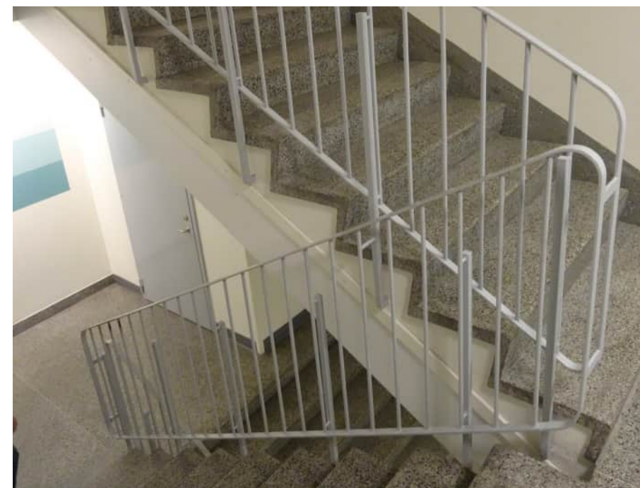
Huvudtrapphuset. Ursprungligt terrazzogolv och trappsteg samt trappräcke i stål.
