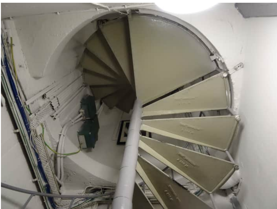
Ursprunglig spiraltrappa i stål, som löper genom flera våningsplan, finns kvar.
