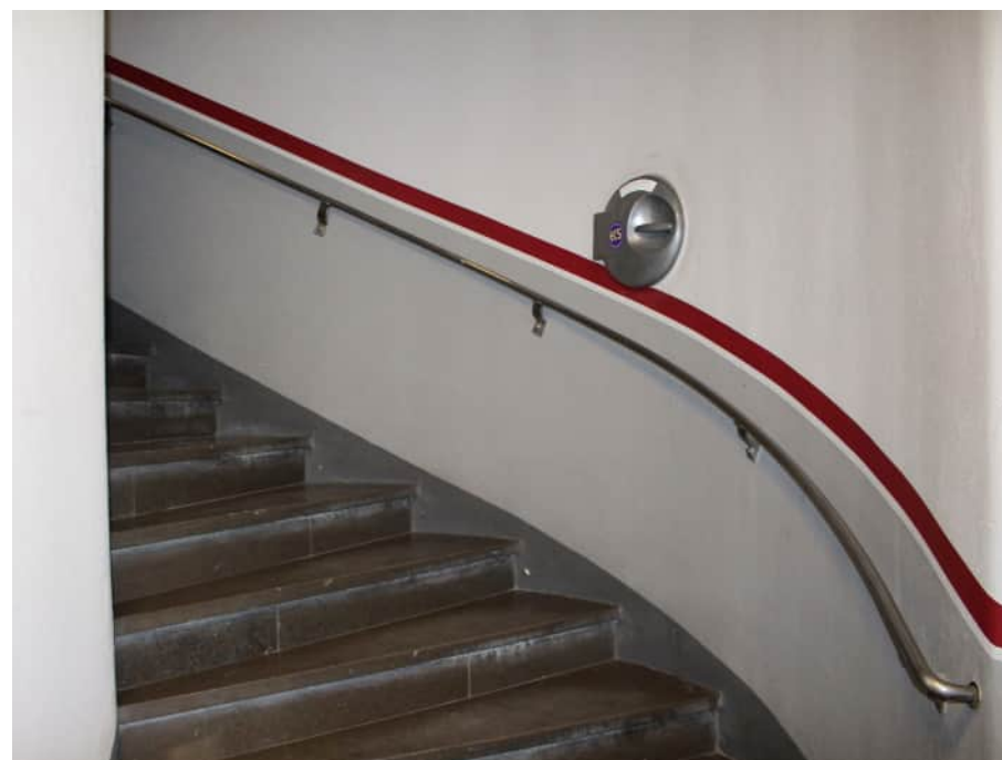
Trappa klädd i kalksten. Lucka för sopnedkast är sannolikt ursprungligt.
