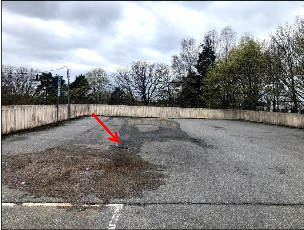
Foto 3. Underbyggda delen av parkeringen i norra delen av PEABs västra kvarter. Dagvattenbrunnens läge markerad med en röd pil.
