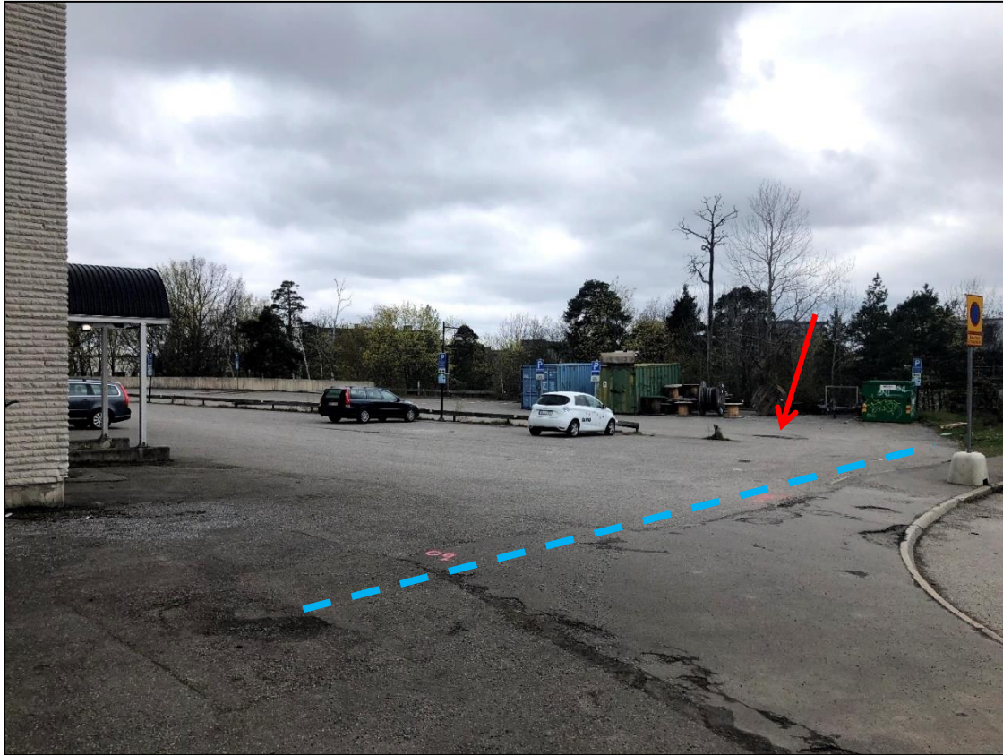
Foto 1. Vattendelare mellan vändplanen och parkeringen i PEABs västra kvarter markerad med blå streckad linje. Lågpunkten ungefärligt markerad med en röd pil.
