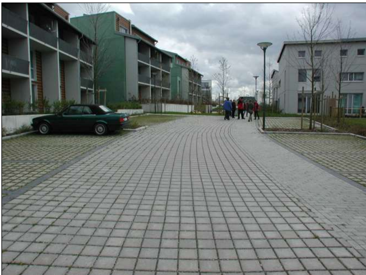
Figur 5-4. Parkering och gata med genomsläpplig beläggning (Foto: Norconsult).
