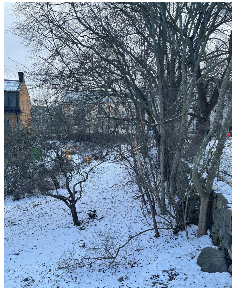
Muren som avgränsar fastigheten Sommaren 10 i väster är äldre än muren längs Tegelviksgatan. Ett antal träd har slagit rot i eller intill murverket. Muren är i dagsläget i behov av åtgärder. Foto Einar Mattsson Projekt AB.
