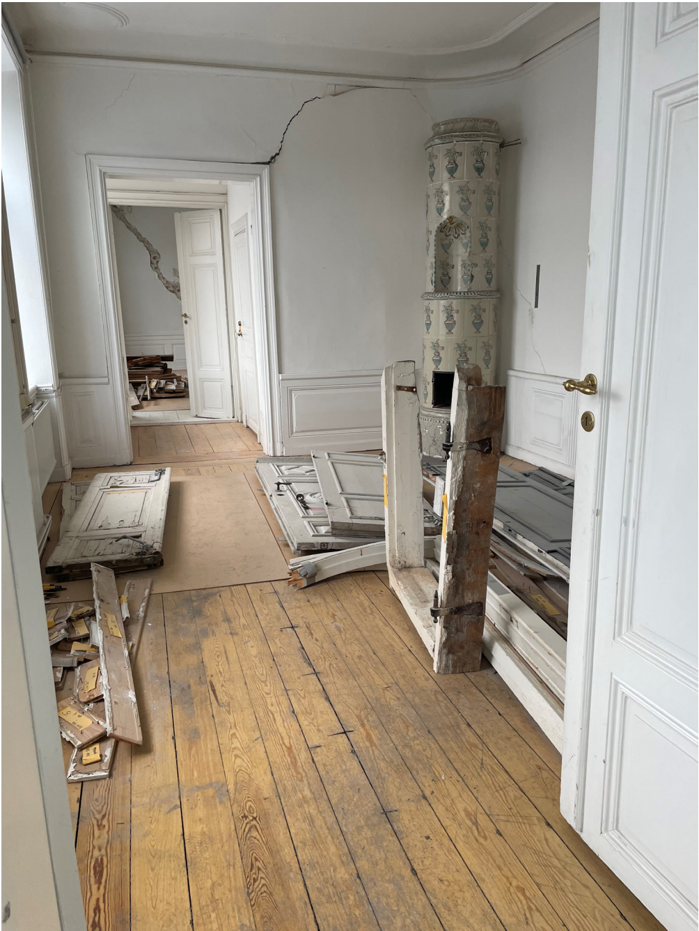
Foto från rumssviten på vån 1 tr där 1700-talsinredning finns bevarad. I samband med utförd grundförstärkning har snickerier demonterats och märkts upp. Foto Einar Mattsson Projekt AB.
