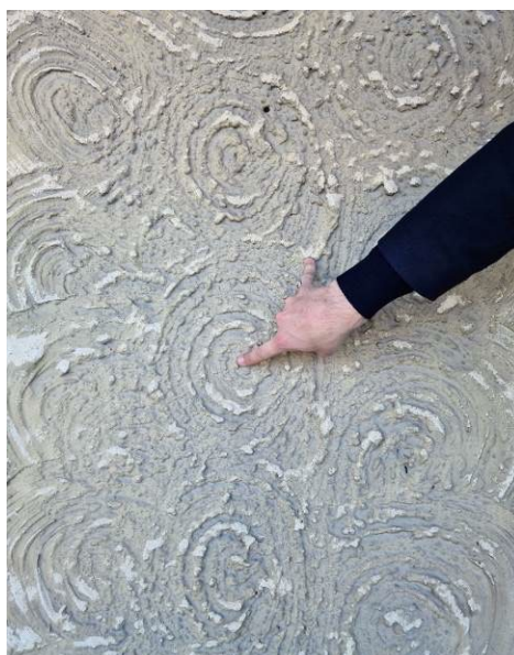
Till vänster: Närbild på den ursprungliga fasadputsen i april 2021, innan putsen togs ner. Till höger: Under platsbesöket samtalades om vikten av att mäta in och dokumentera den befintliga fasadputsens utförande, så att orneringen skulle kunna återskapas i den nya fasadputsen.
