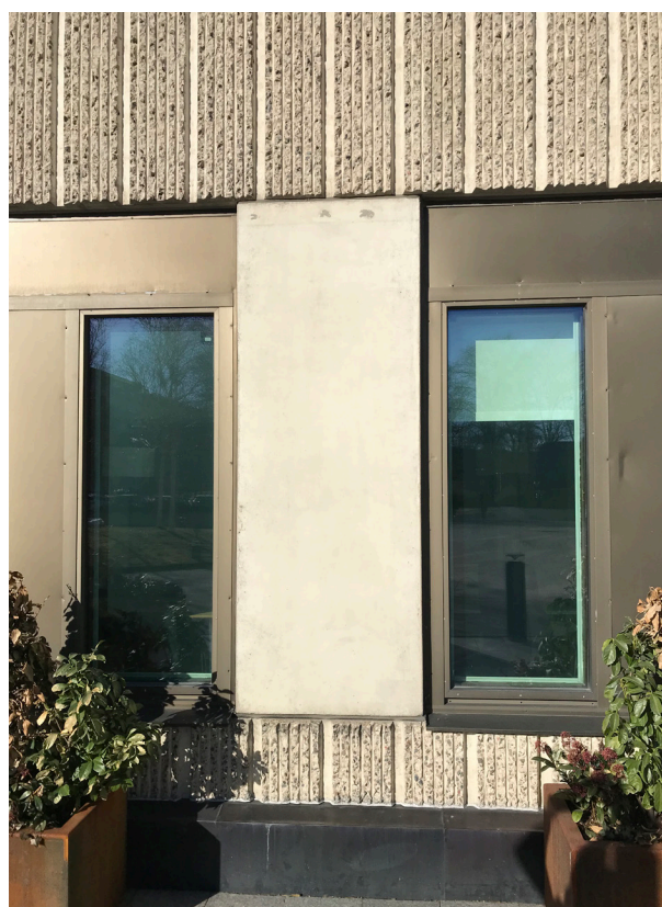
Bröstningselement i betong utfördes med huggen yta, och fasadelement i fönsterband i slätgjuten naturfärgad betong. Fönsterpartier tillverkades i en bronserad kulör. Ursprungligt utförande.
