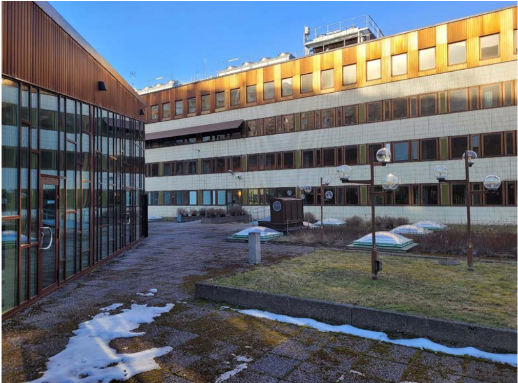
Ändringar inom fastigheten: Ny glasfasad på matsalsbyggnaden, utvändigt solskydd på ett av låghusets våningsplan och skrymmande kylaggregat på takvåningens yttertak.
