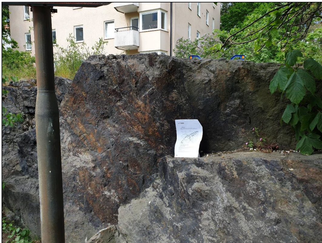
Figur 7. Oxiderade sprickyta vid Sverkersgatan.
