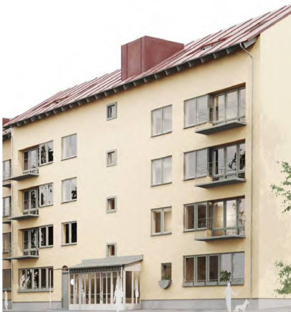
Fönstersättning med grunda balkonger och indrag i fasad mot Blommenbergsvägen
