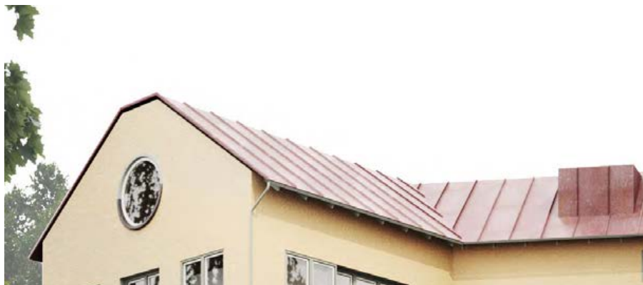
Gavelfönster hus E i korsningen Blommenbergsvägen Erik Segersälls väg och tak med synliga taktassar
