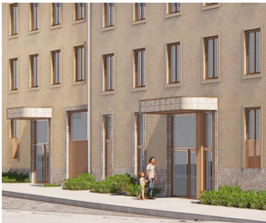
Uppglasade entrépartier med skärmtak och tegeldetaljering
