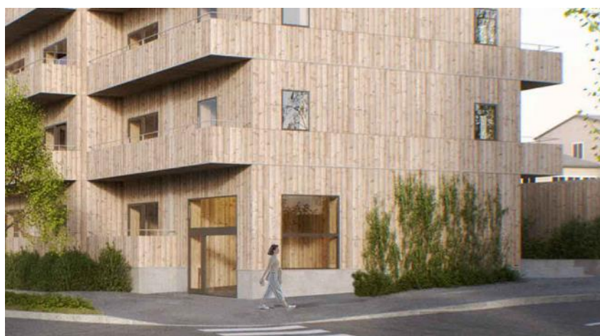
Balkong utformad som en integrerad del av fasad. Entrépartiet ska vara uppglasad och förhöjd. Elementskarvar ska utföras som en del av gestaltningen. In Praise of Shadows Arkitektur AB.
