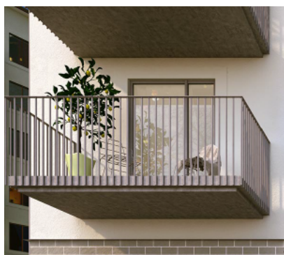
Balkong med pinnräcke. Den kan även utföras med perforerad korrugeradplåt. Balkongplattan i betong får en urspärning i framkant så att den upplevs nättare. Bild White.
