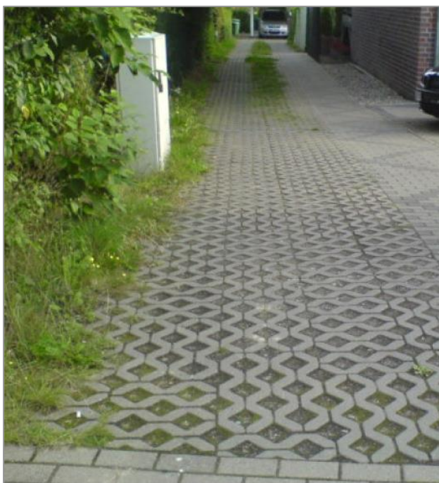
Figur 9-17 Exempel på genomsläpplig beläggning i form av gräsarmerad betongbeläggning (Stockholms Vatten och Avfall, 2017).
