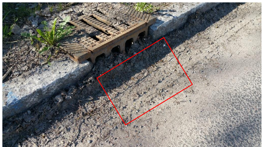
Figur 17. Exempel på skelettjordar och nedsänkta växtbäddar som det kan se ut längs Linta gårdsväg, med brunn DB3. Observera att brunnen kommer att ha intag även i gata (röd yta).
