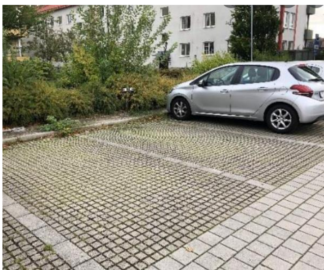
Figur 20. Armerad parkeringsplats för infiltration av dagvatten.
