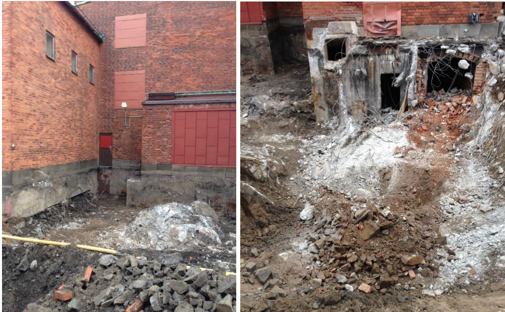
Figur 13. Schakt mot den västra fasaden tillhörande hus 21. Schakt utfördes ner till underliggande berg.
