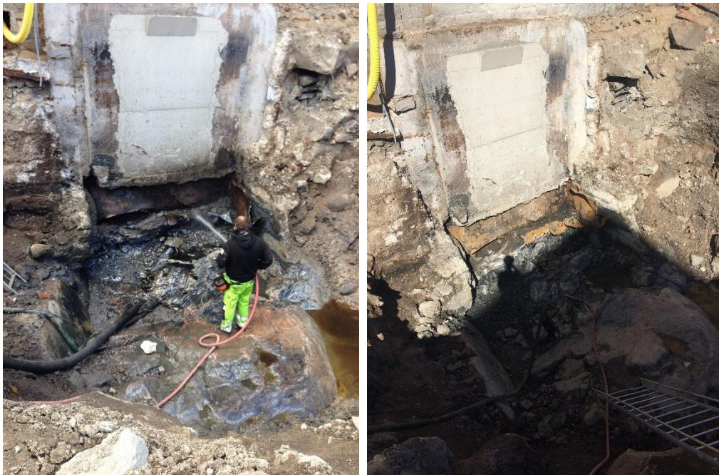
Figur 14. Sanering av tjärföroreningar intill den östra fasaden tillhörande hus 25. Schakt utfördes ner till underliggande berg.
