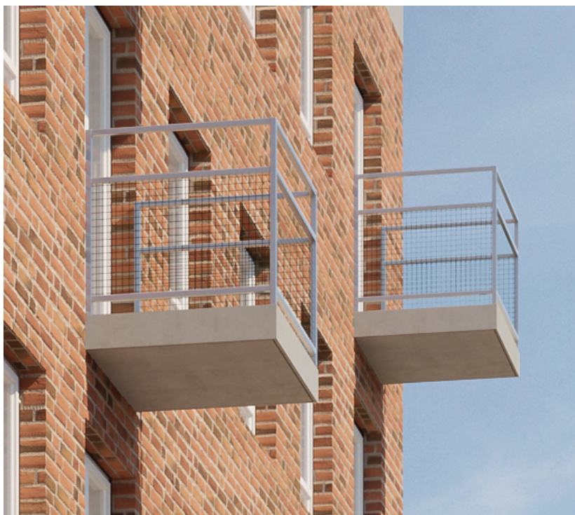
Balkonger. Räcken ska utföras med krenelerat galler eller pinnräcke och med handledare i galvad metall. Balkongplatta ska utföras i grå betong och utan sparkropp (Bild: General Architecture).
