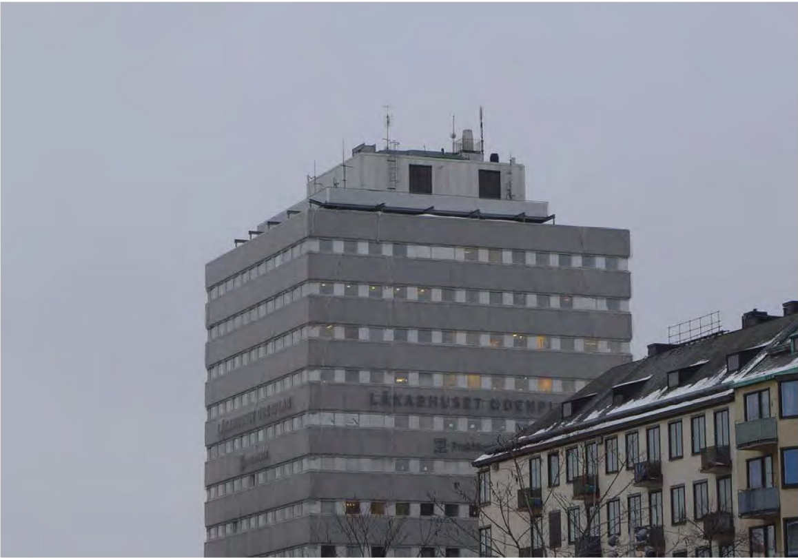
T h högdel inklädd med nät. Utkragande sockelvåning klädd med granit och aluminiumplåt.
