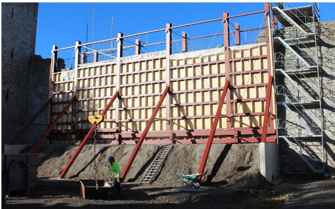
Bild 1. Exempel på temporär stödkonstruktion. (Visby ringmur. Foto Carl Thelin)
