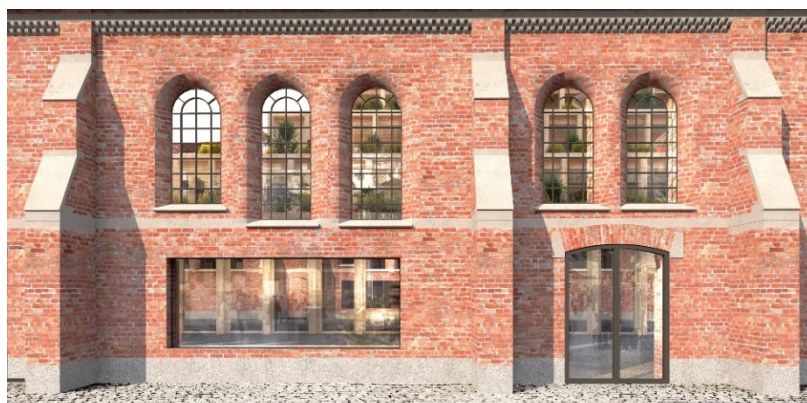
Hus 24: Nya håltagningar för fönster och entré i fasad mot söder
