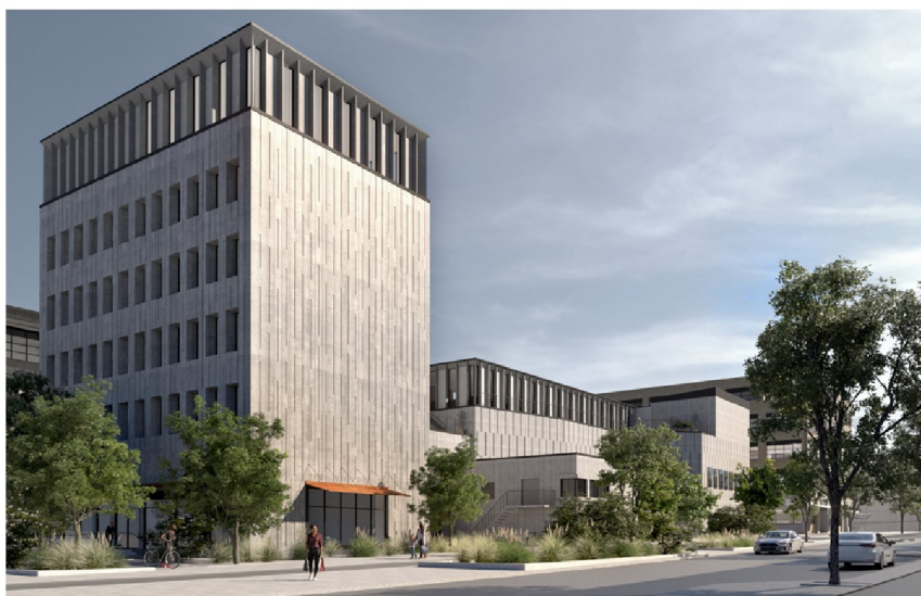
Förslag på om- och tillbyggnad av bevarad del av Lintaverken sett från huvudgatan. Det gamla jetmotorprovhuset föreslås att bevaras och anpassas för ny verksamhet genom håltagning för fönster i ena fasaden och påbyggd våning i avvikande material. Bild: DinellJohansson
