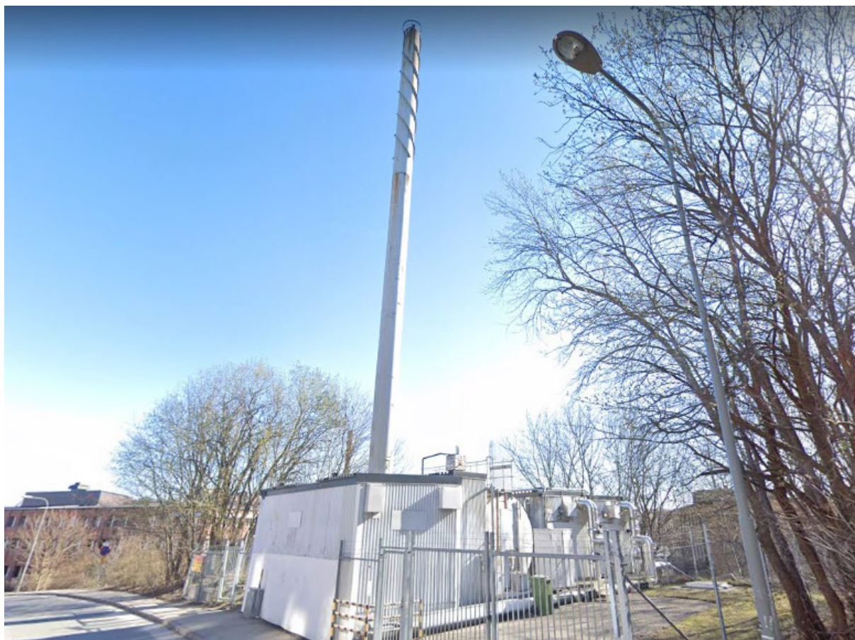
Figur 4. Stockholm exergis fjärrvärmeanläggning vid Selmedalsvägen.
